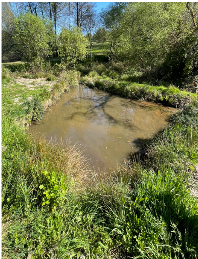
Exemple d'un bassin de décantation permanent
