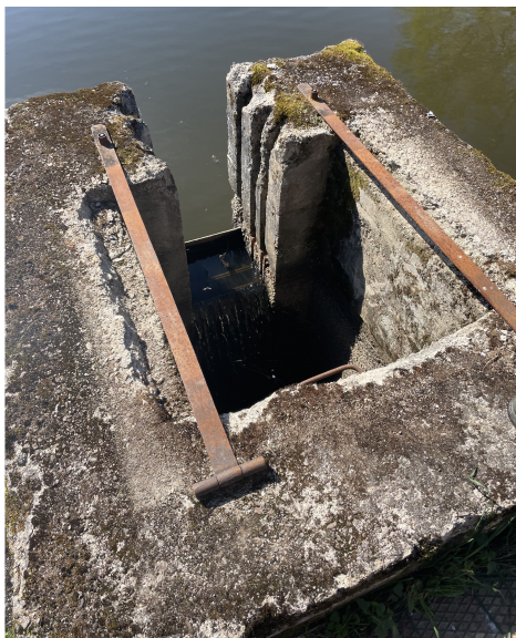
Exemple d'un dispositif de vidange de type moine
