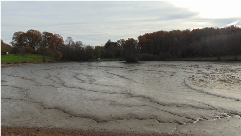
Photographie d'un plan d'eau vidangé, révélant l'accumulation de sédiments
