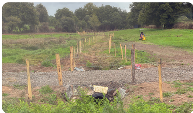
Franchissement de cours d'eau et mise en défens
