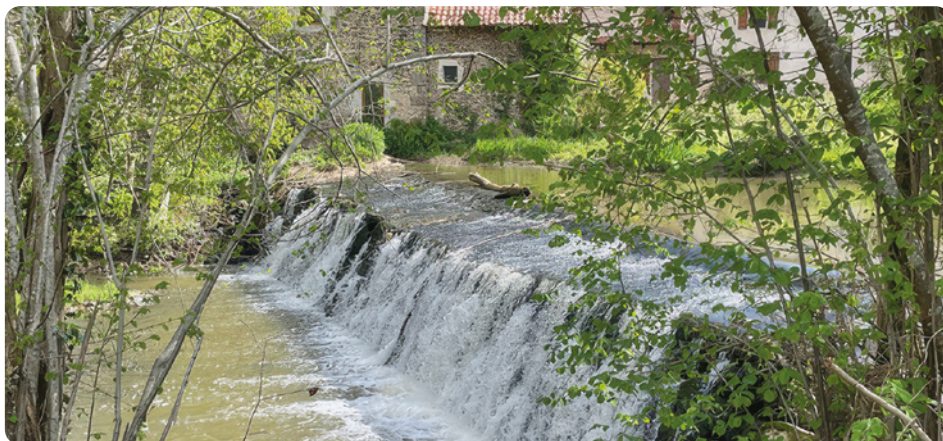
Seuil du moulin des Brosses
